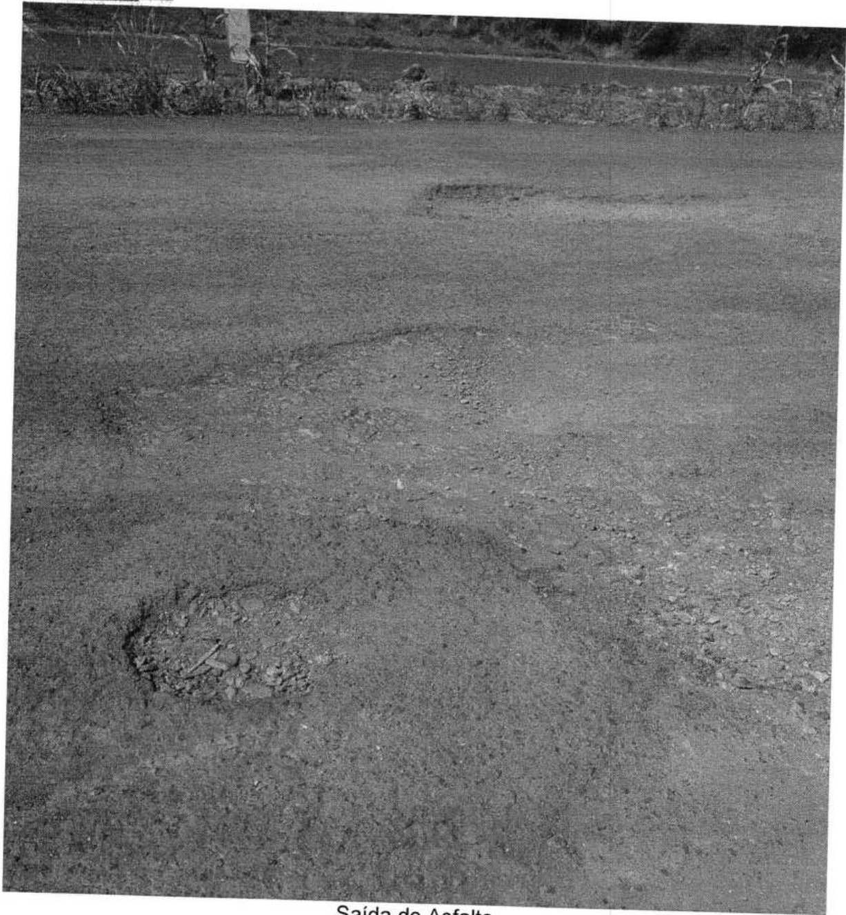
Saída do Asfalto
